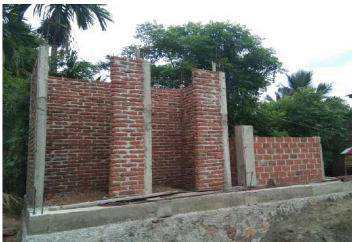
Gambar 2 Tampak Depan Hasil Pembangunan Tahap I Tempat Wudhuk Dan Kullah Air Lembaga Pendidikan Islam Dayah Tarbiyatul Muhtadin Gampong Ateuk Blang Asan Kabupaten Aceh Besar
