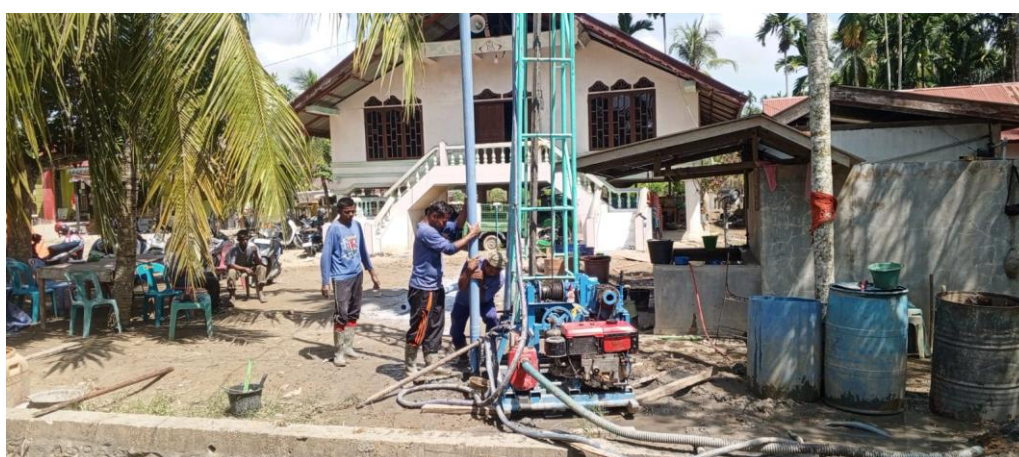
Gambar 2 Kegiatan Pembangunan Sumur Bor
